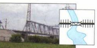
Металлический мост. Насыпь
